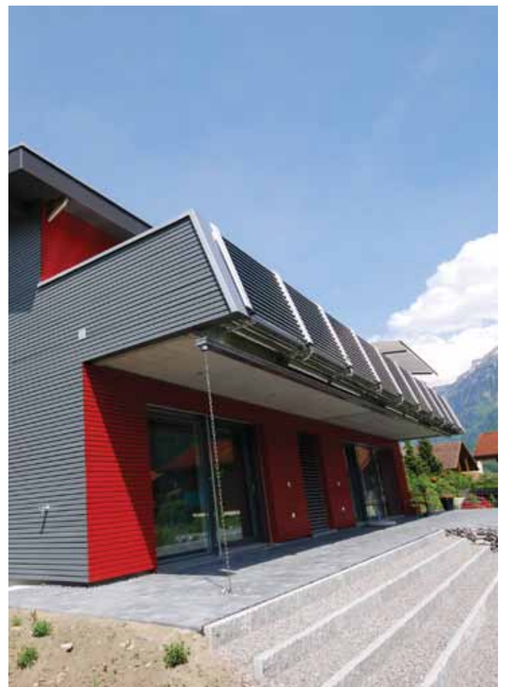
Vakuumröhrenkollektoren an der Balkonbrüstung 68° (Abb.5)
